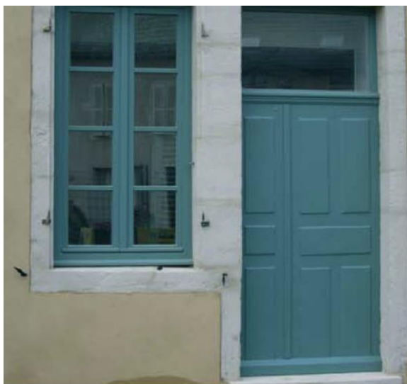
Enduit gratté / lissé (couvrant)
