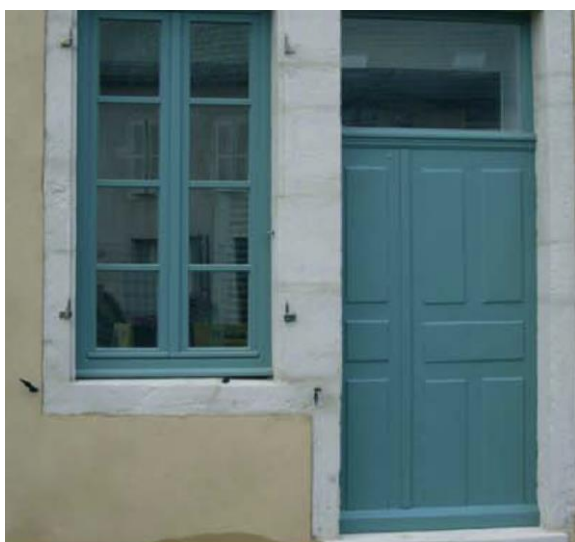
Enduit gratté / lissé (couvrant)
