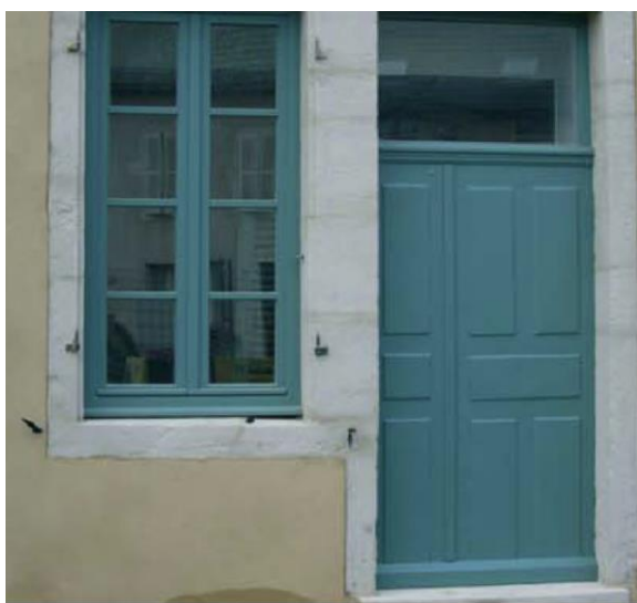
Enduit gratté / lissé (couvrant)
