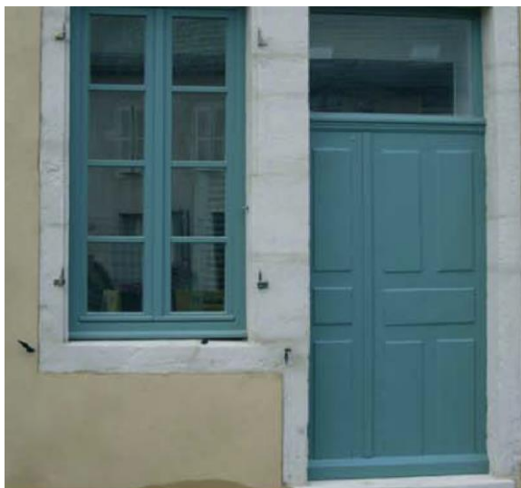
Enduit gratté / lissé (couvrant)
