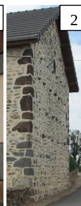
Encadrements de fenêtre (n°1, bourg centre) et chaînage d'angle (n°2, Montglandier) en pierre Volvic
