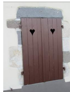
Encadrements de fenêtre (n°1, bourg centre) et chaînage d'angle (n°2, Montglandier) en pierre Volvic
