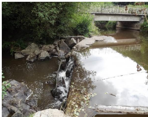
Photo 4 : Seuil sur la Saunade situé à l'ouest de la commune
