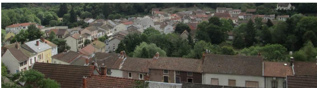
Toitures en tuiles mécaniques - bourg centre
