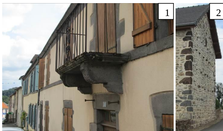
Encadrements de fenêtre (n°1, bourg centre) et chaînage d'angle (n°2, Montglandier) en pierre Volvic
