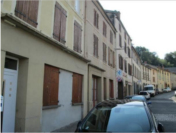
Des façades habillées d'enduit couvrant - centre bourg
