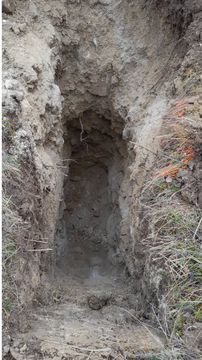
Fond de fouille
