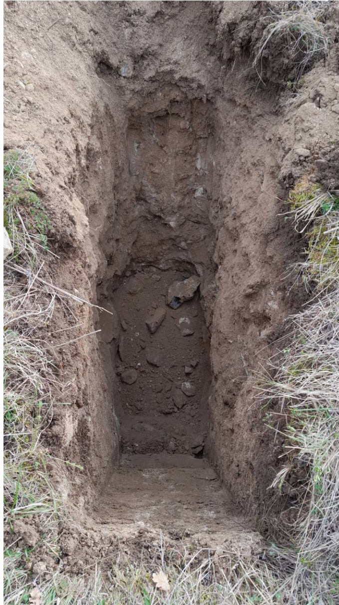
Fond de fouille
