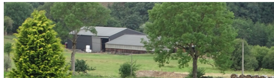
Au Monteillet, décalage des volumes, des toitures et implantation en bas de pente
