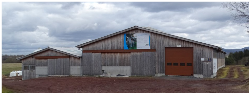
Au Bouchet, décalage des volumes par avancée ou retrait de la façade
