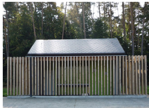
Sanitaires (Condat en Combraille, 63 - source : Vincent Brugerolles)
