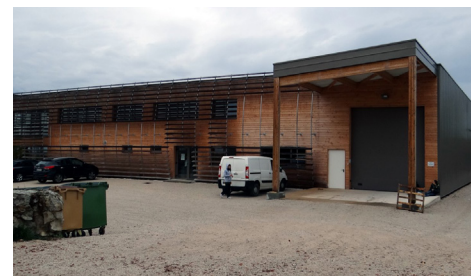
Sols entièrement perméables (Rignac, 46)
