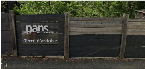
Clôture liée à l'activité historique du site (Travassac, 19)
