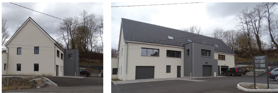
Le bâtiment d'activité existant en secteur Am
