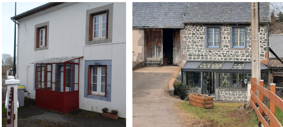
Exemples de vérandas qui s'inscrivent dans l'architecture de la construction principale
