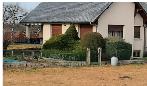
Exemple de clôture transparente : muret surmonté d'un grillage souple
