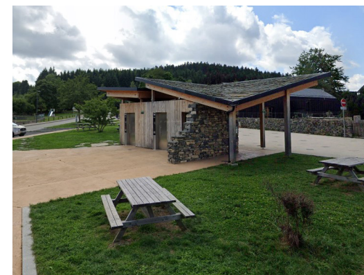
Abri, toilettes et départ de randonnée (Le Pertuis, 43 - Source : BIGBANG Paysage)
