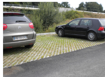
Stationnement perméable et végétalisation du parking (Malemort, 19)
