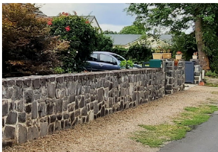
Exemple de clôture récente en pierre de pays avec mortier
