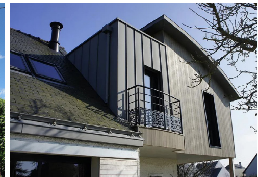
Exemple d'extension latérale plus haute que la construction principale avec une accroche au bâtiment existant réussie : travail sur les lignes (source : Safran-constructionbois)
