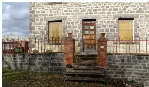
Exemple de clôture avec mur bahut surmonté d'une grille
