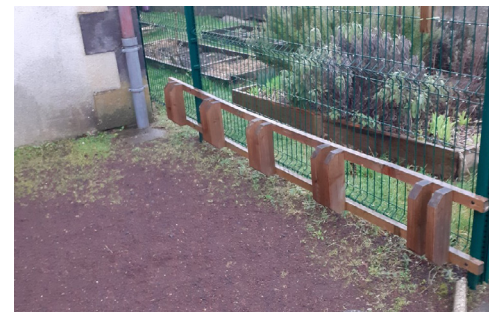
Espace à vélos réalisé en chantier participatif pour l'école d'Olby
