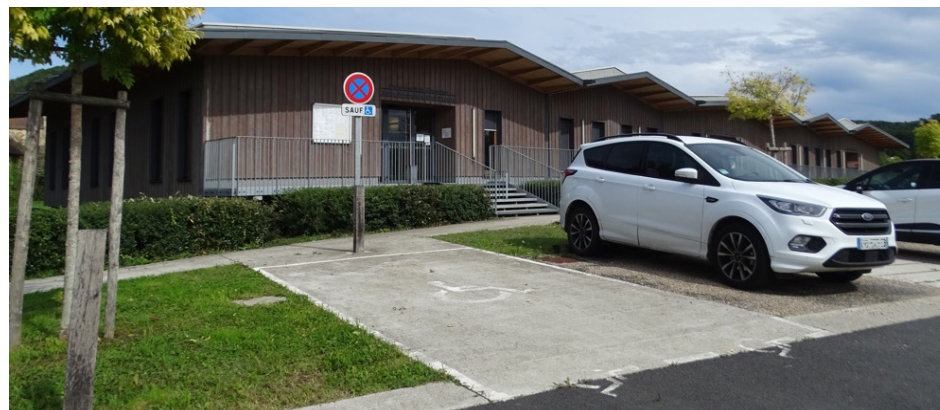
Exemples de stationnement perméable : ici, environ 70% de la surface est perméable (Saint-Cyprien, 24)
