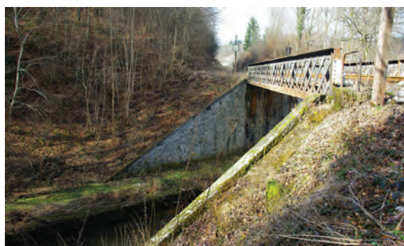
4. Chemin à aménager avec passage sous le pont de la voie ferrée
