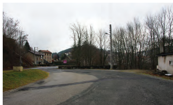
3. Délaiée de la route nationale à aménager en parking et espace public
