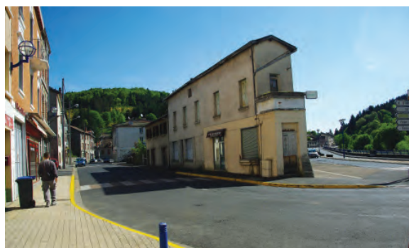
5. La rue de la Gare au niveau de l'îlot central à requalifier
