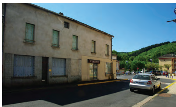
Bâtiment en mauvais état dans l'espace central
