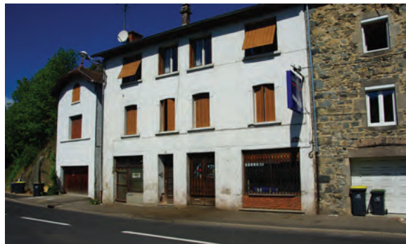
Réhabilitation possible et réouverture de commerce à étudier
