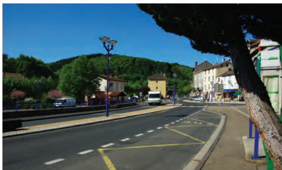
Traverse à transformer en espace de vie au niveau de la gare TER à réouvrir aux voyageurs
