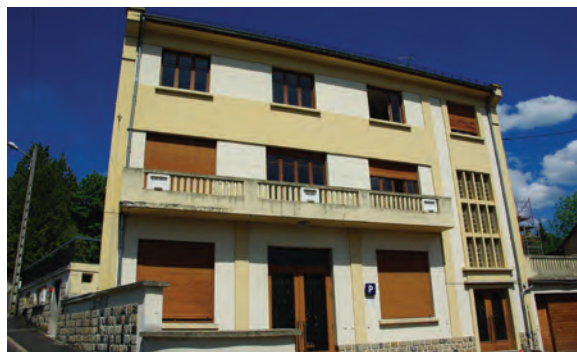
Maison des Associations en cours d'aménagement
