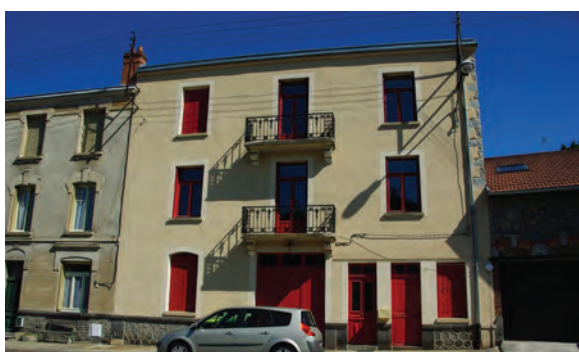
Exemple de rénovation de qualité
