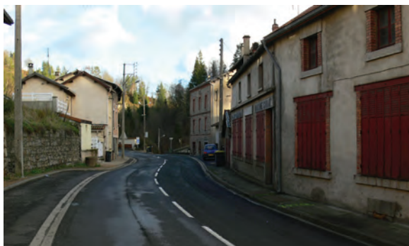
Façades à améliorer et bâtiments à réhabiliter rue du 14 Juillet
