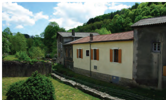
Bief au niveau de la Grande Roulière
