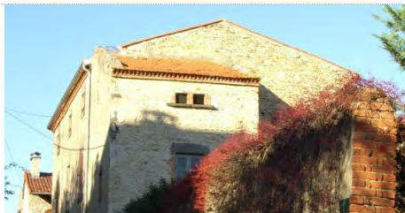
Toiture traditionnelle à 2 pans, toiture faible, recouverte de tuile de teinte rouge (tuile canal, tuile mécanique).
