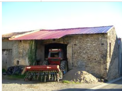
Le bac acier remplace souvent les toitures des bâtiments agricoles. La teinte rouge permet de conserver une certaine harmonie.
