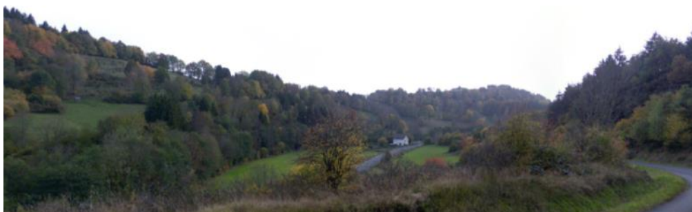
La vallée de la Miouze avec la ligne de chemin de fer
