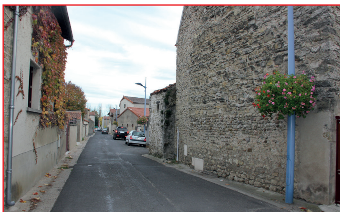
Partie de la rue la plus proche du carrefour central - maisons anciennes
