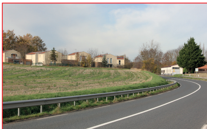
Entrée de bourg Sud - aspect routier important mais les constructions récentes et l'aménagement de la partie à gauche en cours font évoluer le paysage
