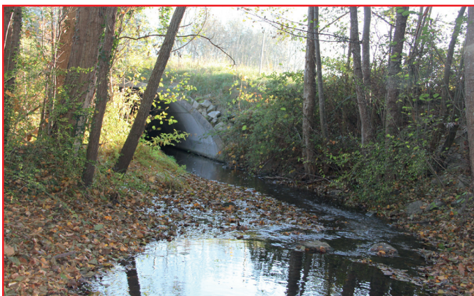
Passage souterrain du Chambaron sous l'autoroute
