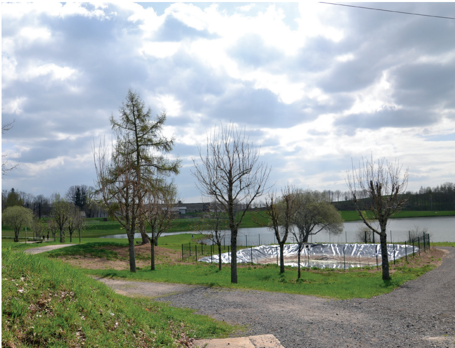
Bassin de rétention fermé, dénaturant visuellement le plan d'eau touristique et son milieu naturel en arrière plan. De plus, les arbres ont été éêtés, leur port naturel estropié, qui pourtant si élégant, et leur santé fragilisée.
