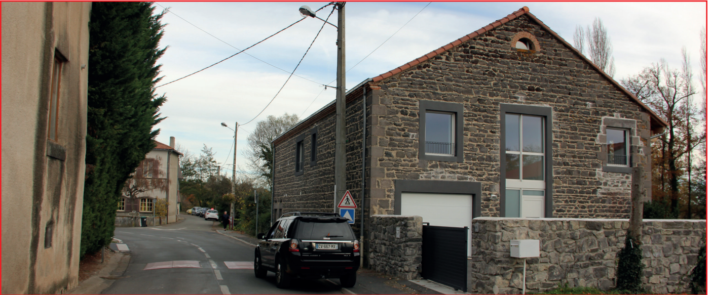
Bâtiment rénové vers l'école
