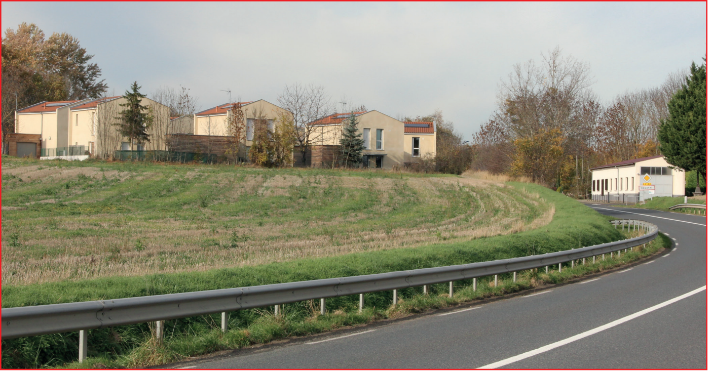
Opération de logement individuels groupés à l'entrée Sud du Bourg
