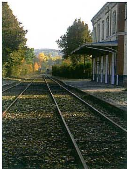
La fermeture de la ligne SNCF au trafic voyageurs en 1971 a figé le paysage ferroviaire dans son état d'alors. Cet état de fait est une opportunité du point de vue touristique.
