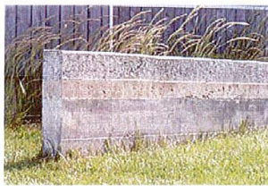
Exemple / Mur de clôture en béton brut
