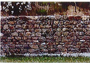
Exemple / Mur de clôture en pierre
