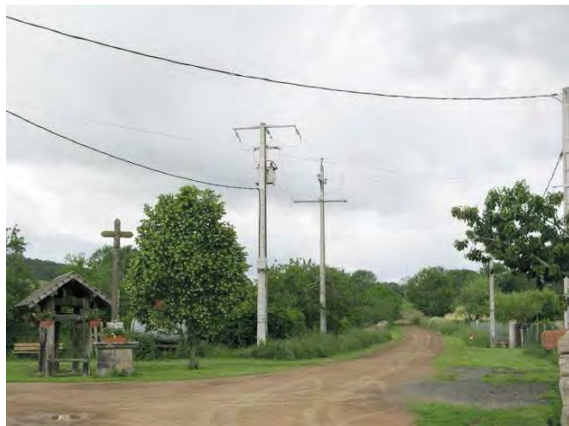
Chauviat : fils électriques au-dessus d'un espace de village bien entretenu
