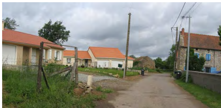
Constructions neuves au sein du tissu ancien (La Tour Serviat) rupture dans les modèles et dans les implantations
