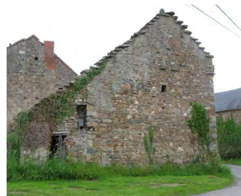
Pignon à « pas de moineaux » : ces pierres plates servaient d'appui pour positionner le chaume sur la toiture tout en protégeant la tête de mur. On les retrouve fréquemment dans la commune. (le passage du chaume à la tuile ou l'ardoise s'est fait au XIX, voire début XX).
