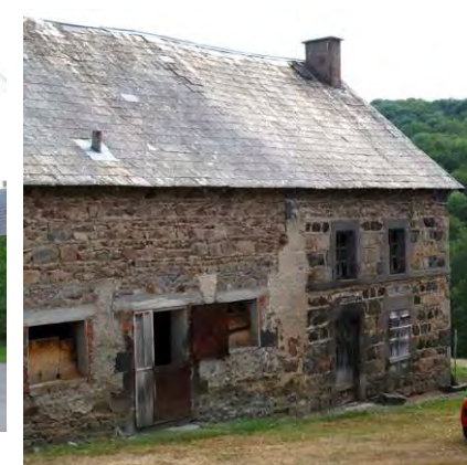
Ensemble remanié (maison bloc allongée) composé du logis, de la grange et de l'étable. Elle est couverte en ardoises. On remarquera sur cette construction que la façade du logis est en Pierre taillée ; alors que la grange était crépie et montée en pierres de ramassage plus ordinaires.
