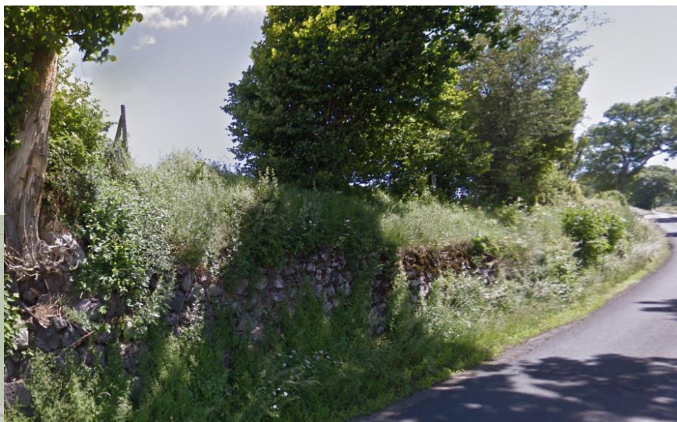
...et d'un empiérement en partie Sud de la parcelle ZA 244.
