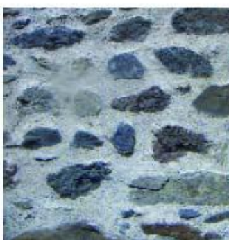
Enduit traditionnel à la chaux naturelle
