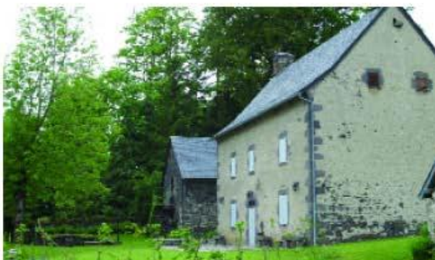
Enduit traditionnel à la chaux naturelle
