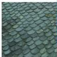
Non régulière, l'ardoise d'Espagne est dite « à pureau dégressif ».
