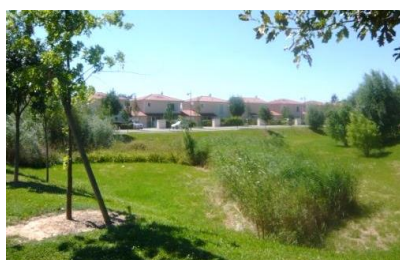
Exemple de traitement des eaux pluviales
