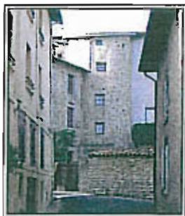
Tourelle au centre du bourg
