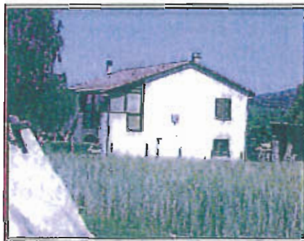
Extension pavillonnaire au Couzon
