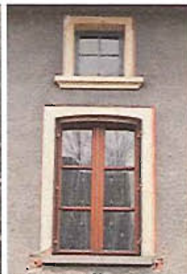
Encadrements de fenêtre.
