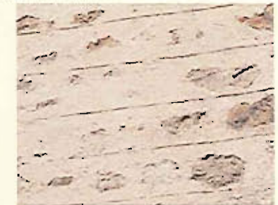
Les lits de pierre étaient parfois soulignés d'un trait horizontal, réalisé dans le mortier frais avec le fer de la truelle, appelé layage.
