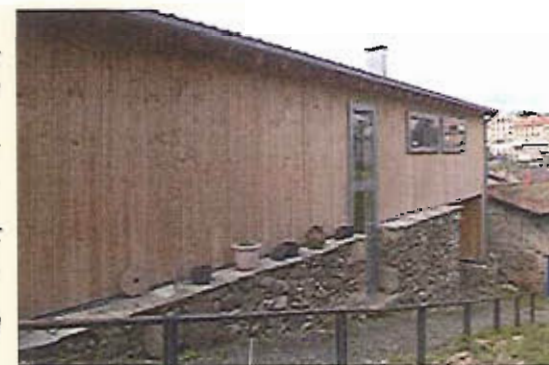
La structure bois vient se poser sur le mur de clôture reconstitué.
