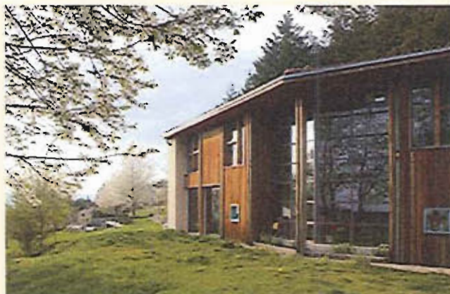
La façade de la maison, exposée au sud, est réalisée en ossature et bardage bois, les murs pignons et la façade nord sont en maçonnerie traditionnelle.
