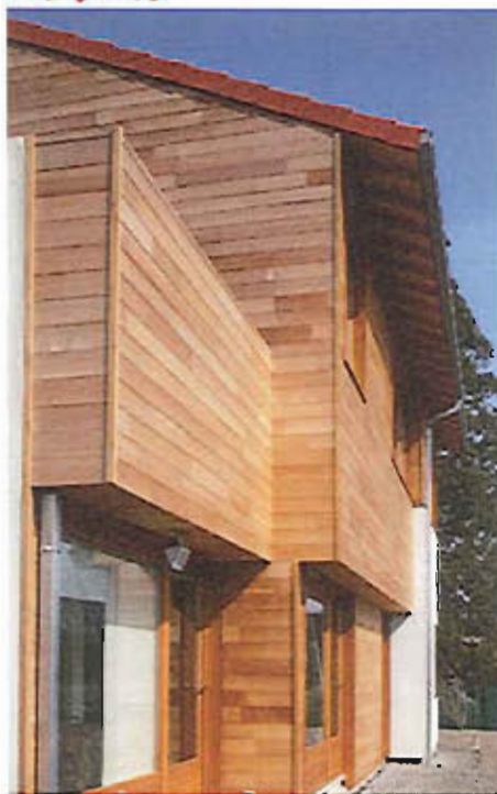
Maison en bois massif préfabriquée en atelier
