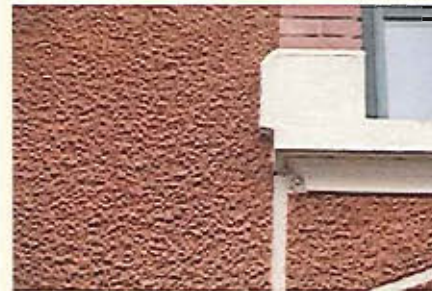
Les enduits « jetés au balai » identifiables par un grain épais, sont caractéristiques des constructions édifiées entre 1920 et 1950, lors de l'essor industriel de la vallée.
