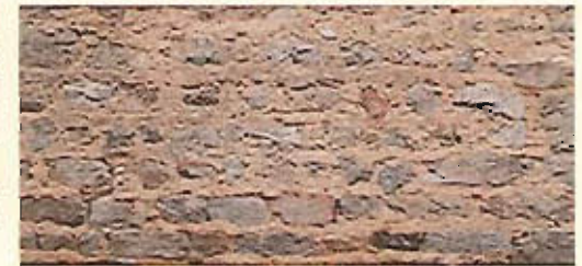
Les jointoyements sont réalisés à « fleur de pierre » afin d'étauchifier au maximum les interstices.
