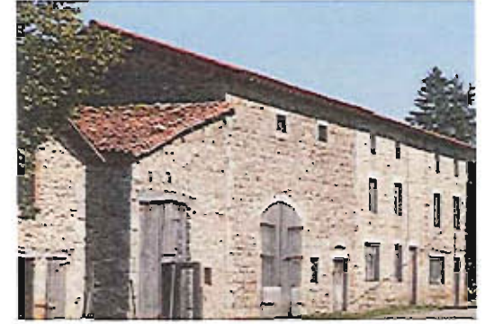
Dans les hameaux, les constructions isolées étaient simplement jointoyées.
