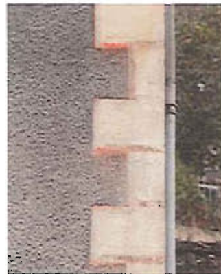
Chaînage d'angle harpé.
