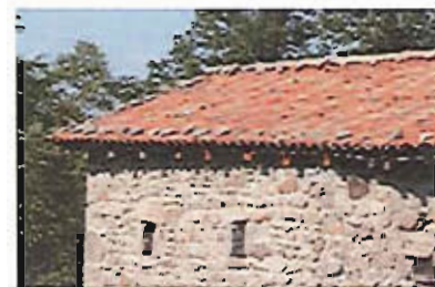
Toit rénové avec des tuiles de récupération posées sur une sous-toiture.
