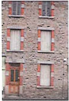
Façade jamais enduite. Les encadrements d'ouvertures en saillie attestent de la volonté d'enduire ultérieurement.
