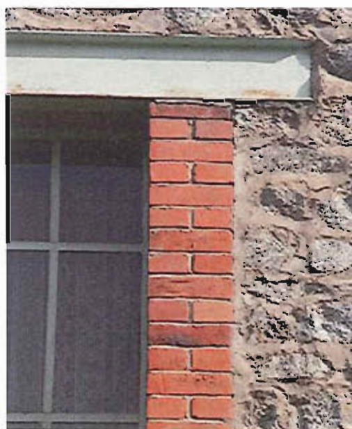
Les linteaux métalliques utilisés pour les ouvertures de certains ateliers sont caractéristiques de la région thiernoise.
