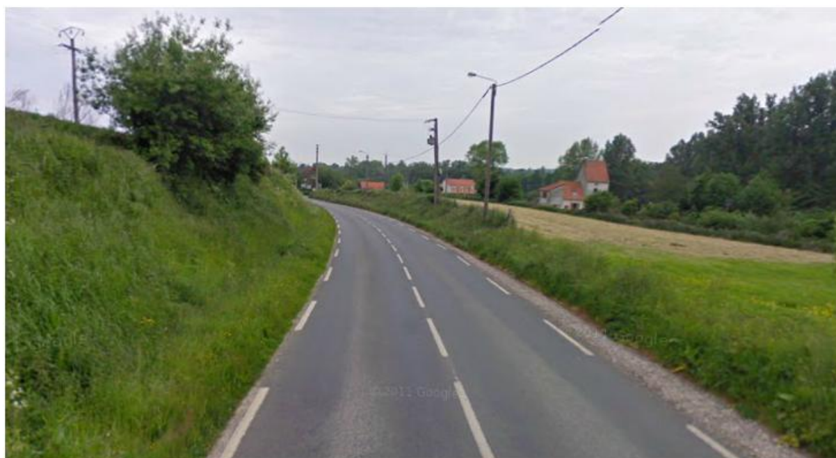
Talus rue de Fruges
