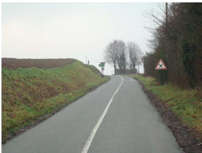
Talus à l'ouest de la rue de Fruges
