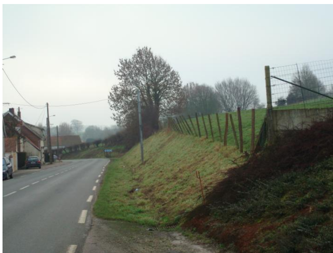
Talus rue de Fruges
