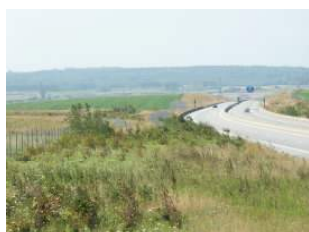
L'autoroute A 16, traverse le territoire communal du nord au sud.
