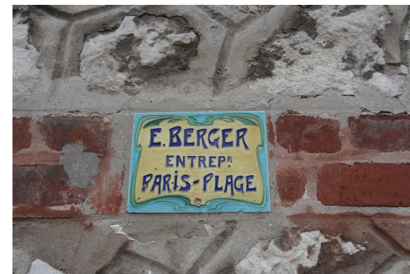
Parement mixte : pierre, faux pans de bois, encadrements en briques sur chant ....
