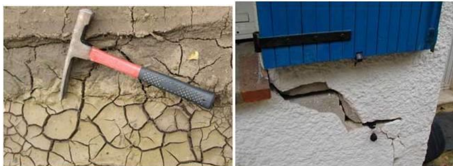
Schéma illustrant le fonctionnement de l'aléa retrait/gonflement des argiles et Représentation des dégâts liés au risque retrait gonflement des argiles
