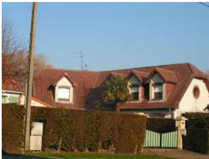
Cette construction récente située rue du Général de Gaulle, tranche par sa volumétrie importante
