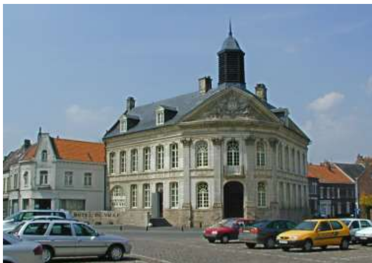
L'Hôtel de Ville vu depuis l'Eglise (ci-contre)
