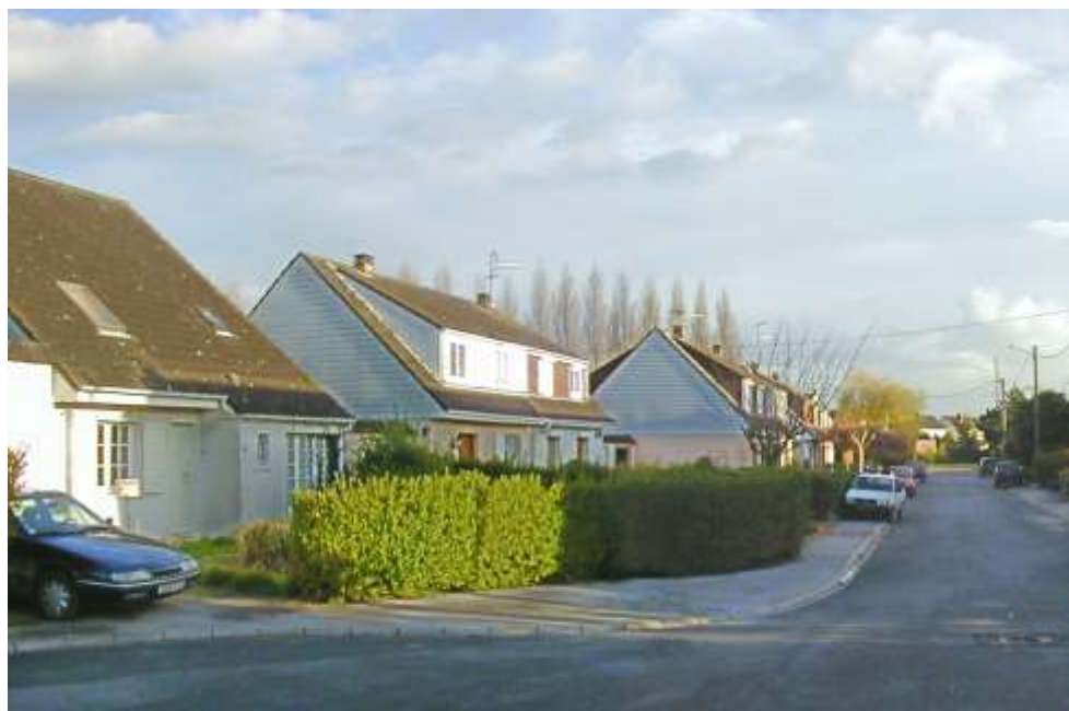
La Cité Floris – Lotissement situé au Nord de la route
