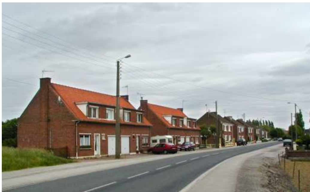
Urbanisation linéaire le long de la Route de Saint-Floris
