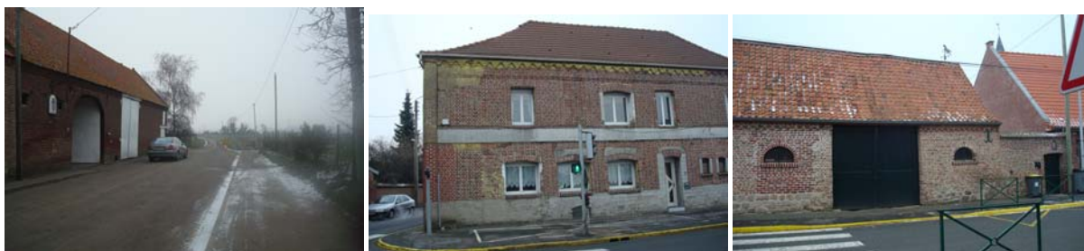
Rue d'Annequin, un corps de ferme- le long de la RD953, une imposante bâtisse- rue de Noeux, face à l'école
