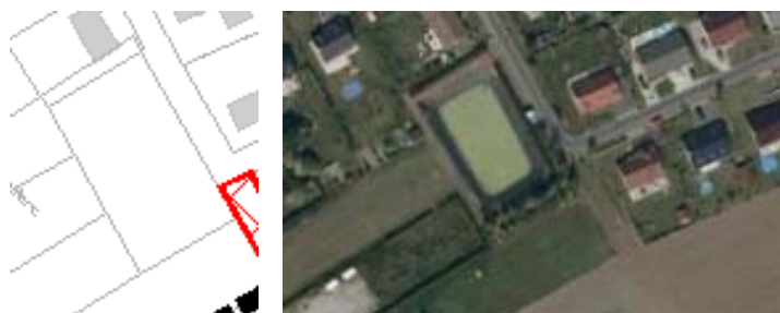
Bassin de rétention de la résidence Le Clos du Fief
