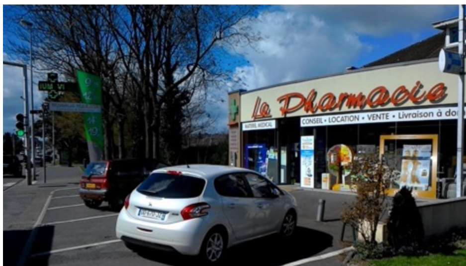
Enseigne scellée au sol de grand format (13,5 m2)- non conforme, boulevard Winston Churchill, Arras
