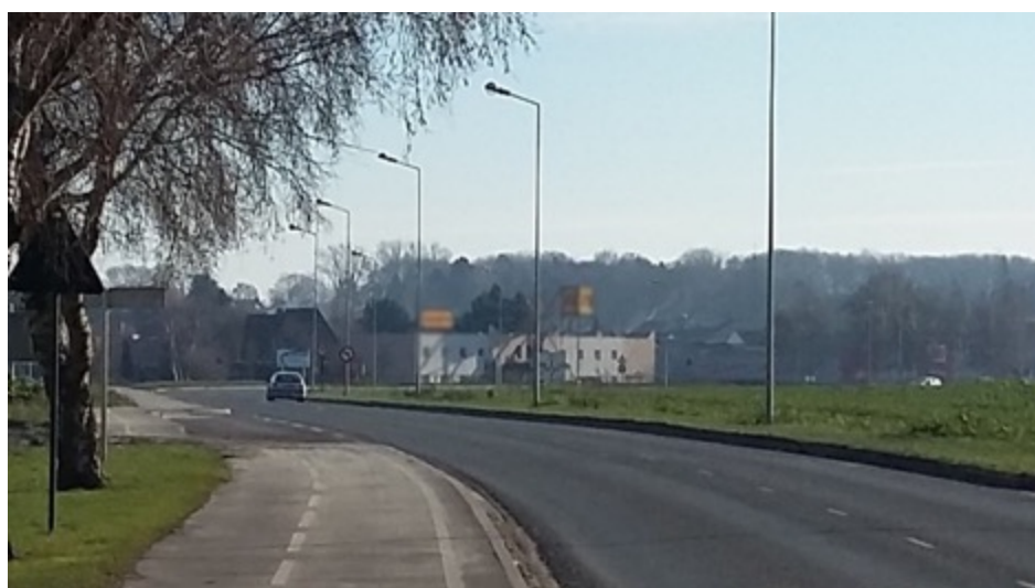
Enseigne scellée au sol de grand format (illégal) ayant un fort impact paysager, zone industrielle Est, CUA
