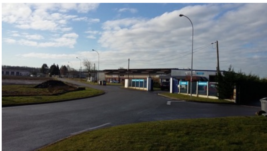
Enseigne parallèle et sur clôture ayant peu d'impact paysager, parc d'activités de Dainville-Achicourt
