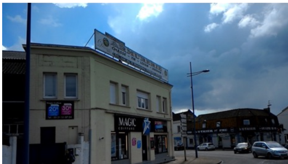
Préenseigne sur toiture non conforme, RD917, Arras
