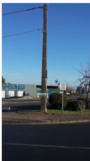
Préenseigne illégale apposée sur un poteau de télécommunication dans le parc d'activités de la Tourelle à Achicourt
