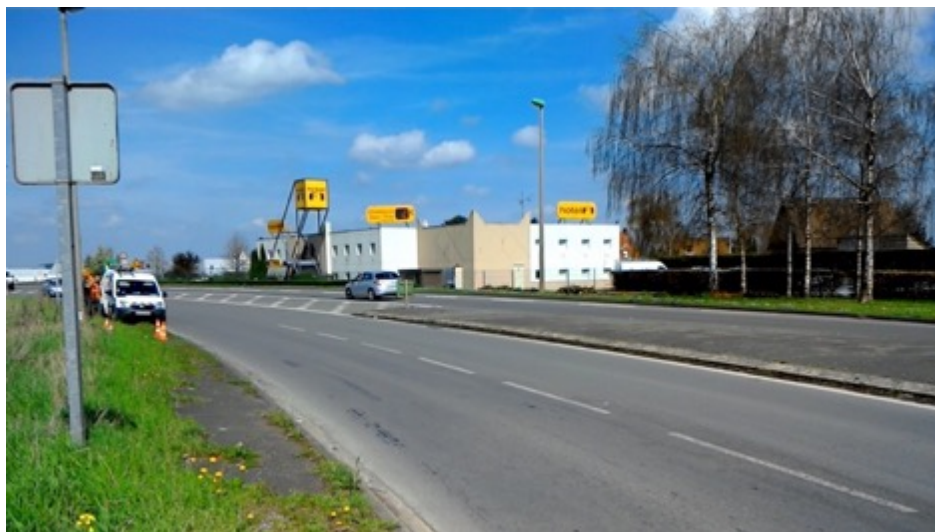
Enseignes sur toiture avec panneau de fond - non conforme, RD60, Tilloy-les-Mofflaines
