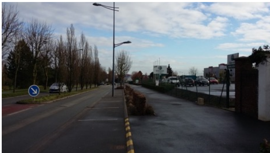
Enseigne scellée au sol dépassant 6 m 2 , parc d'activités de Dainville-Arras Sud Ouest
