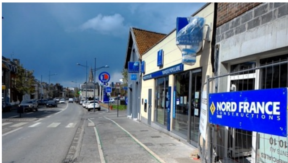
Covisibilité entre enseigne scellée au sol de grand format (18,5 m 2 ) - non conforme et Beffroi, RD917, Arras
