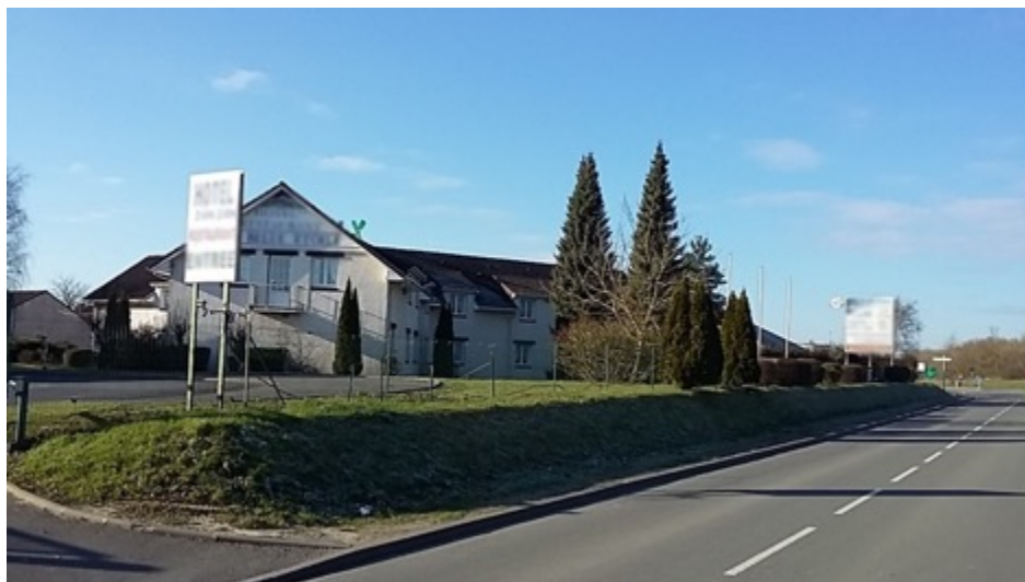
Enseignes scellées au sol en surnombre, Saint-Nicolas-lez-Arras
