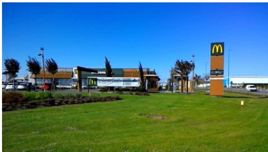
Enseignes scellées sur le sol - (totem : 8,8 m 2 ; bâche: 6,3 m 2 ) - non conforme > 6 m 2 , RD60, Beaurains
