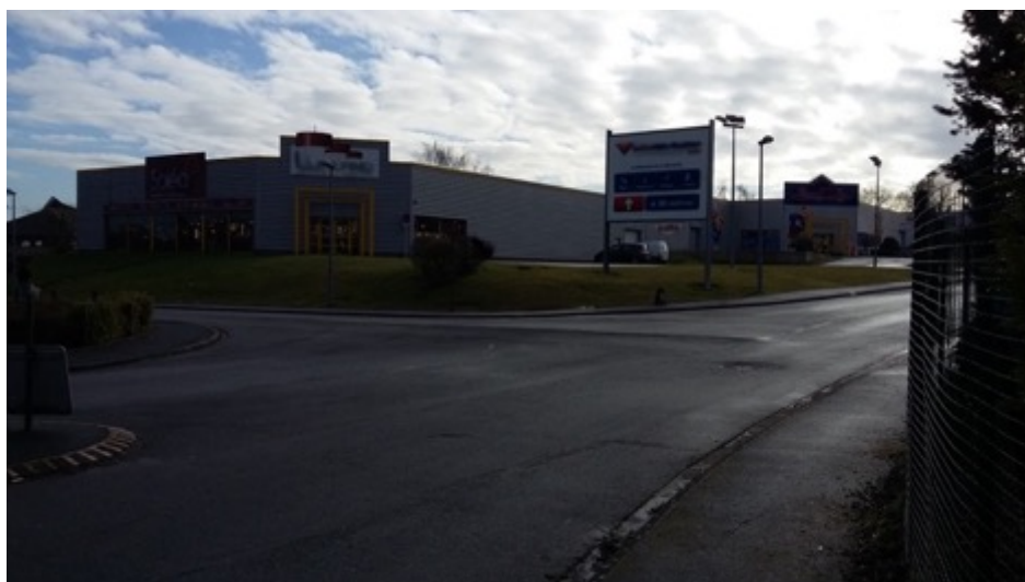
Préenseigne scellée au sol de grand format illégale et enseigne parallèle dépassant les limites du mur, parc d'activités de Dainville-Arras Sud Ouest
