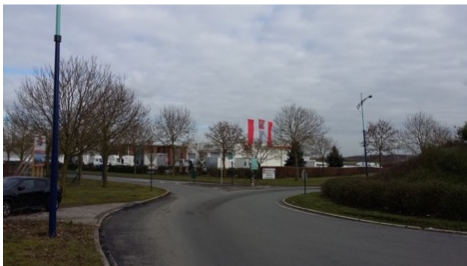
Enseignes scellées au sol ayant un fort impact sur le paysage, zone de l'Artoipôle
