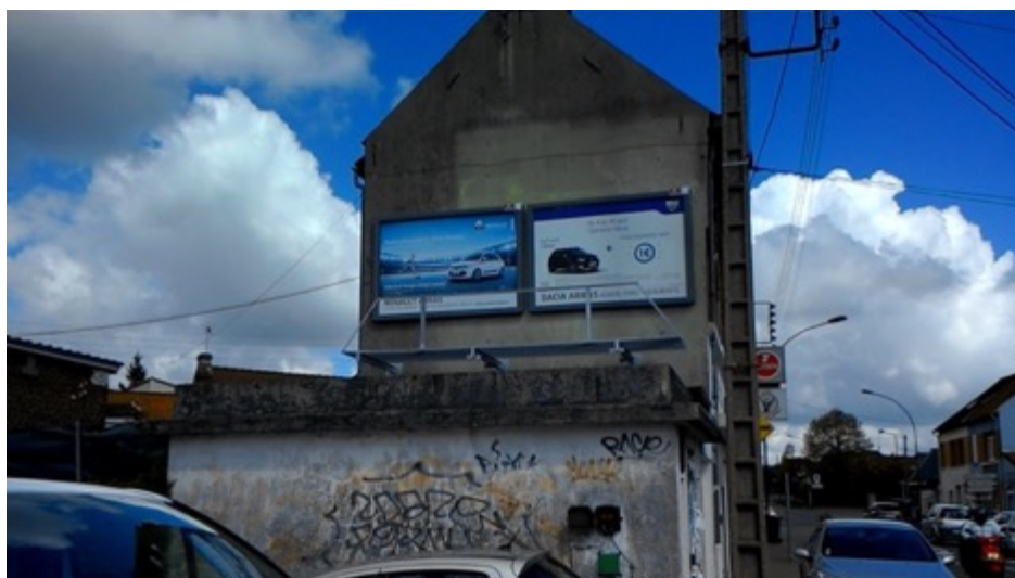
Densité importante de publicités murales (4m2) avec passerelles d'accès, RD919, Achicourt
