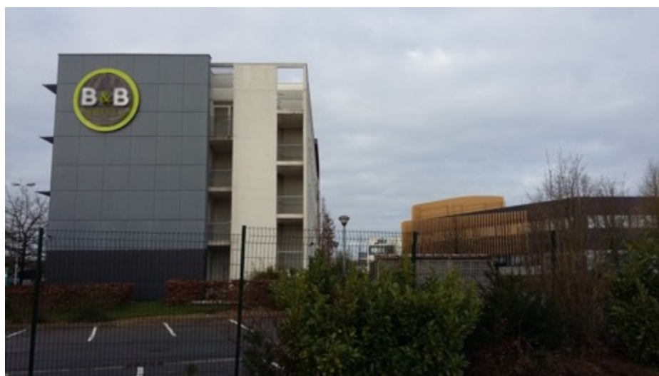
Enseignes parallèles au mur ne posant pas de problème paysager, parc des Bonnettes à Arras
