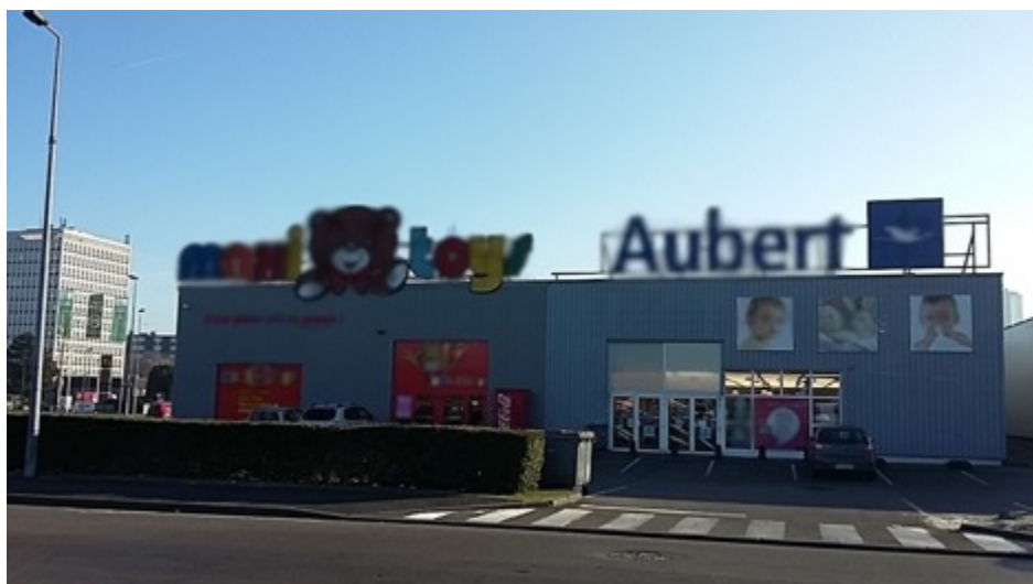
Enseignes sur toitures peu intégrées au cadre paysager de la zone, zone d'activités Ouest, Arras
