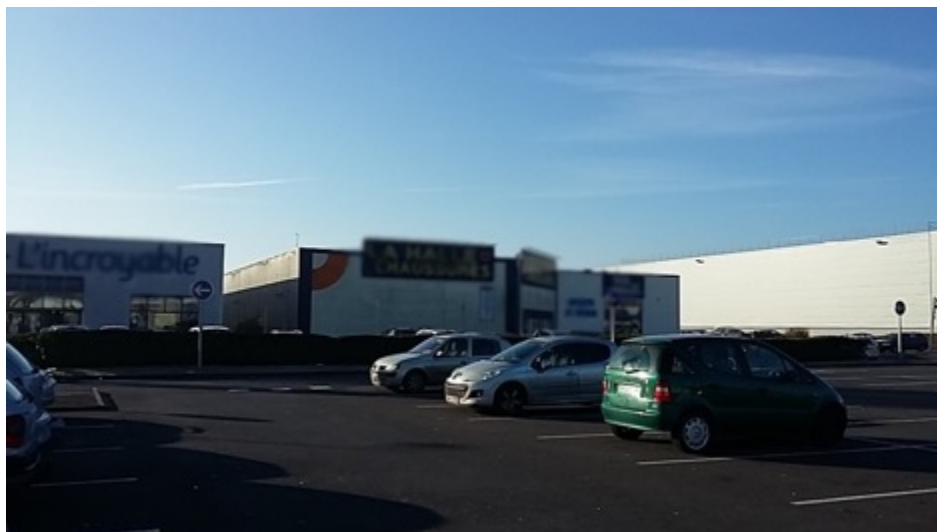
Enseignes parallèles au mur dépassant la limite du mur, zone d'activités Ouest d'Arras
