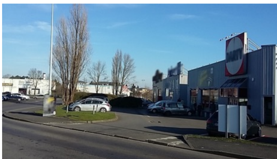
Enseignes sur toitures ou parallèles peu intégrées au cadre paysager de la zone, zone d'activités Ouest, Arras
