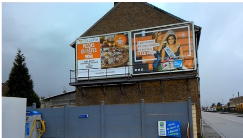
Densité importante de publicités murales (12 m2) avec passerelles d'accès, RD919, Arras
