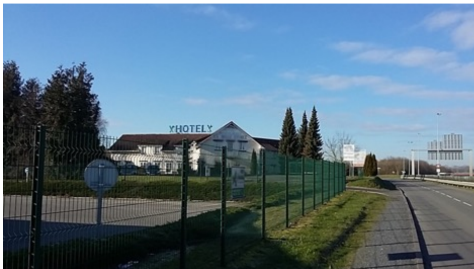
Enseigne sur toiture, Saint-Nicolas-lez-Arras
