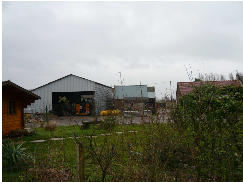
Bâtiment d'activité agricole le long de la Grand'Rue
