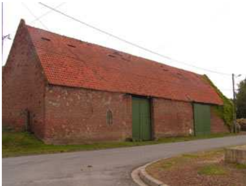
Ancienne exploitation agricole située Grand'Rue
