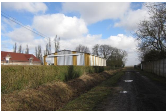
Le chemin de desserte à restructurer et le fossé à maintenir
