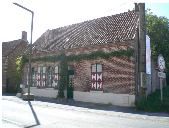
Maison en front-à-rue rue Nationale
