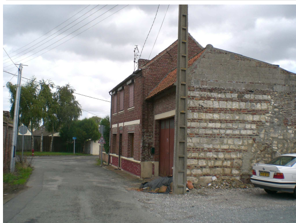
Maison en front-à-rue rue de l'Eglise
