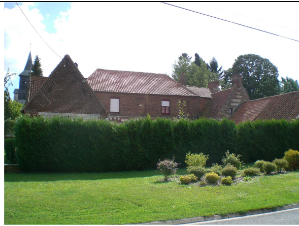
Presbytère rue Jules Ferry
