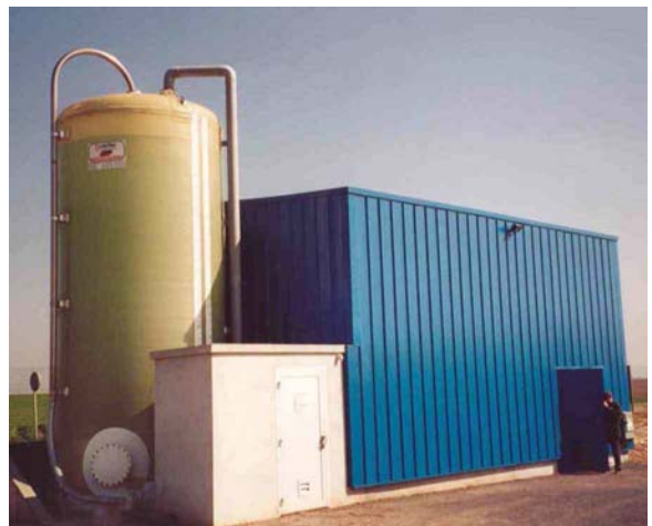
Unité de dénitratisation de Beaumont
