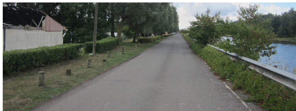
La véloroute le long de la Deûle
