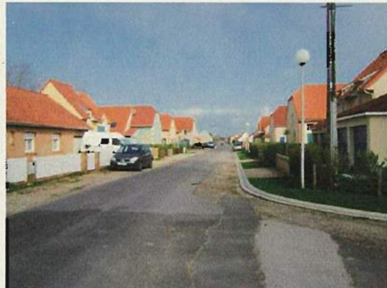
Exemple du traitement des voies secondaires sur Merlimont-Plage.
