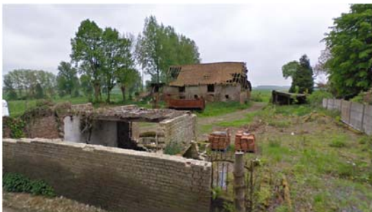
Vue sur le terrain concerné, comportant une construction à l'état de ruine en entrée de village sur le RD104
