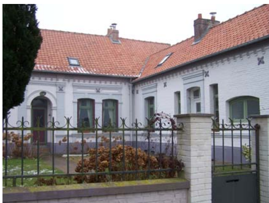
Une ferme réhabilitée
