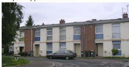
Habitat locatif années 60: R+1+combles, bâti enduit avec parement brique, toiture à 2 pentes, couverture en tôle, construit en retrait par rapport à la route.
