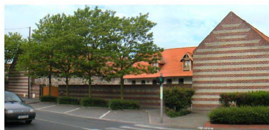
Corps de ferme: R+combles, construction en brique et pierre blanche, toiture à 2 pentes, couverture en tuiles, en forme de U.
