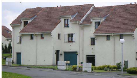
Habitat locatif années 90: R+1+combles aménagés, bâti enduit, toiture à 2 pentes, couverture ren tuiles, construit en retrait par rapport à la route.
