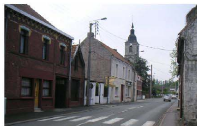
Habitat traditionnel: R+1+combles, construction en brique, toiture à 2 pentes, couverture en tuiles, en front à rue.
