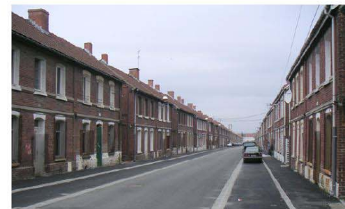
Habitat minier groupé: R+1+combles, construction en brique, toiture à 2 pentes, couverture en tuiles, en front à rue.
