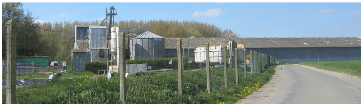
Ensemble de bâtis à vocation économique situés au nord du tissu urbain
