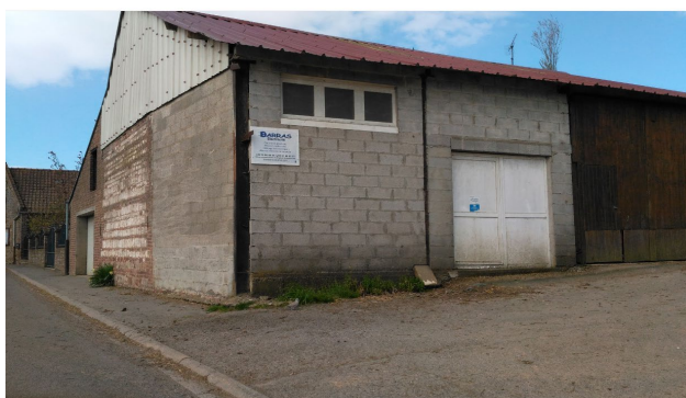
-BARRAS Electricité ; photographie Urbycom-
