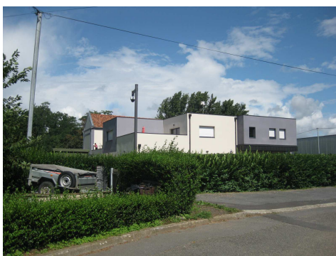
Logements collectifs, chemin de l'entraîneur
