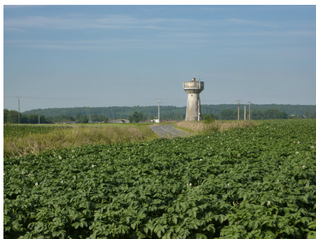
Château d'eau, rue du 19 mars 1962
