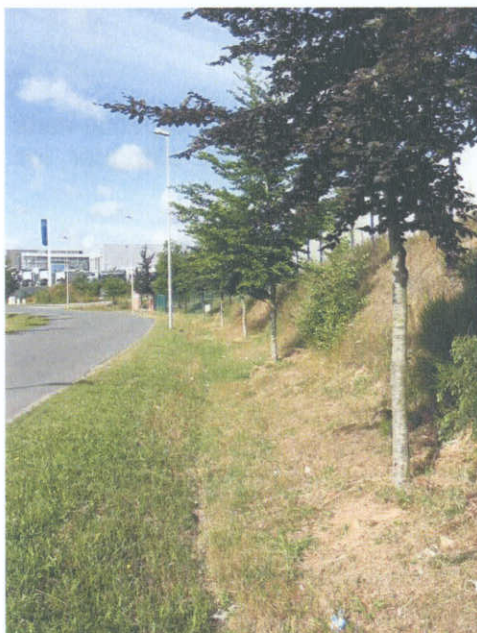
Noue en bordure d'une voie interne de zone industrielle
