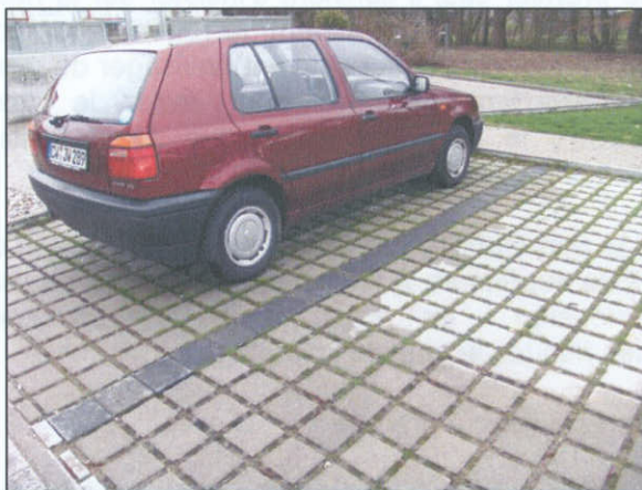
Exemple de pavés à joints non étanches permettant l'infiltration des eaux
