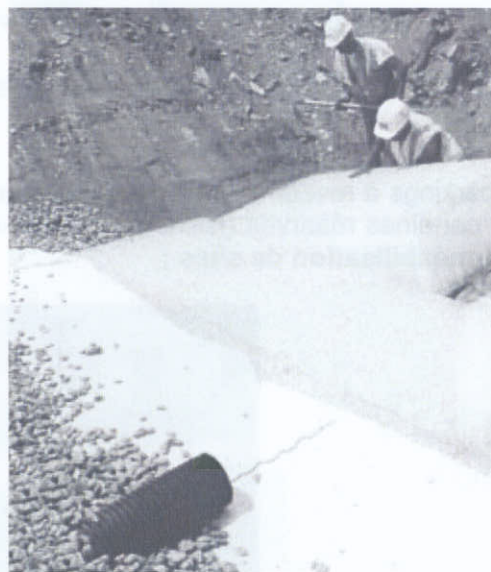
source : Nidoplast (mise en œuvre en cours)
