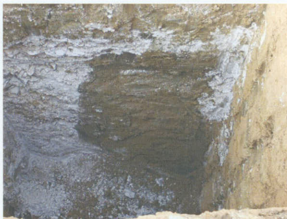
Détail de la discontinuité du substrat calcaire
