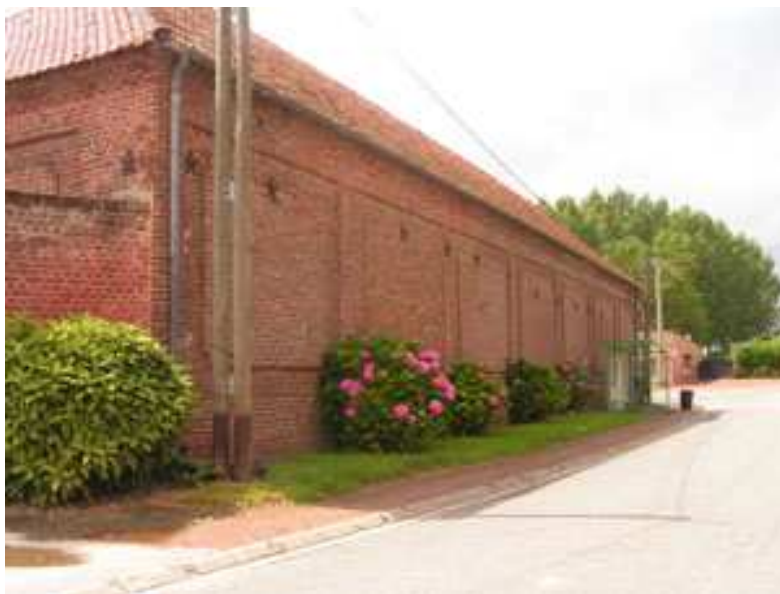
Construction agricole insérée au sein du village (rue du Calvaire)
