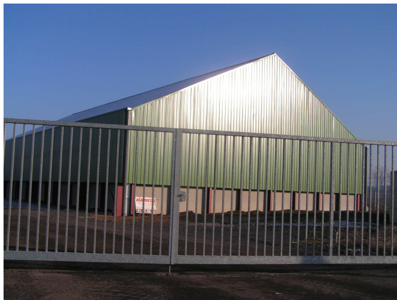
Bâtiment de stockage de grains situé en entrée de village
