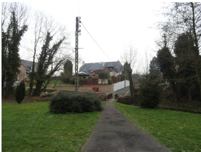
Passerelle rue de la Bourgogne
