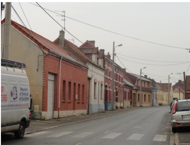
Habitat mixte ancien implanté à l'alignement
