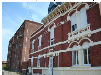
Réhabilitation des bâtiments à l'arrière en appartements
