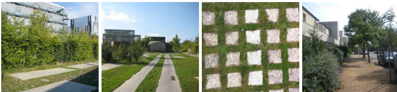
Exemples illustratifs : graviers, dalle sur pelouse, stabilisé ou terre armée, pavés drainant ou à joints engazonnés, bande déroulement.
