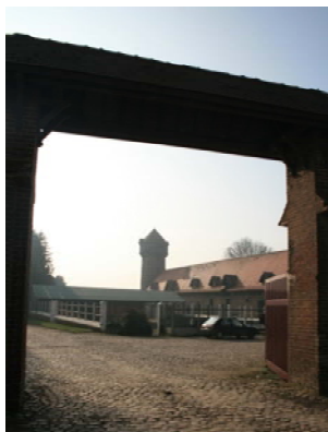
Ancien château rue du Général De Gaulle
