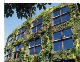
Exemple de mur végétal :
