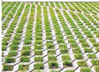
Exemples de stationnement perméable :
