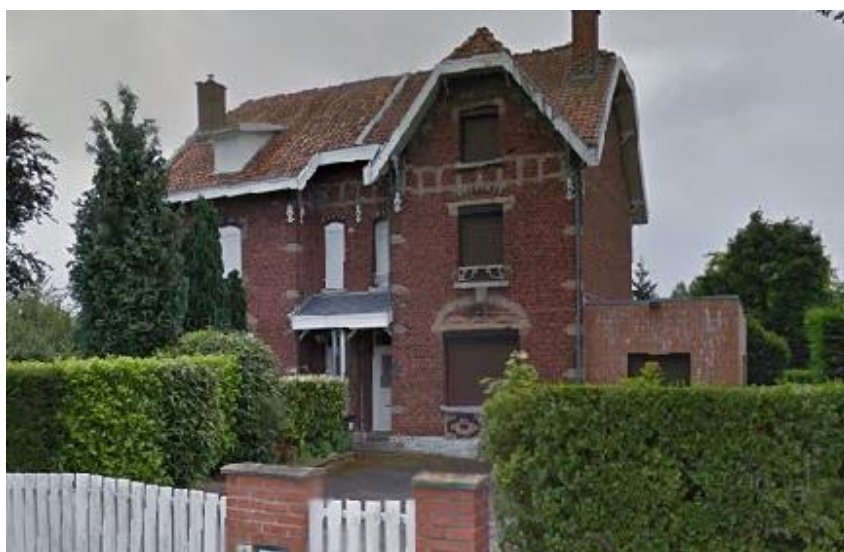
Maison d'ingénieur Avenue Josien
