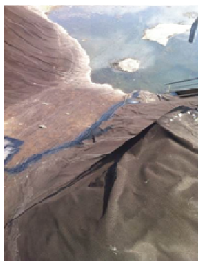
Bassin Harnes rond-point - rue Pierre jacquart (après travaux)
