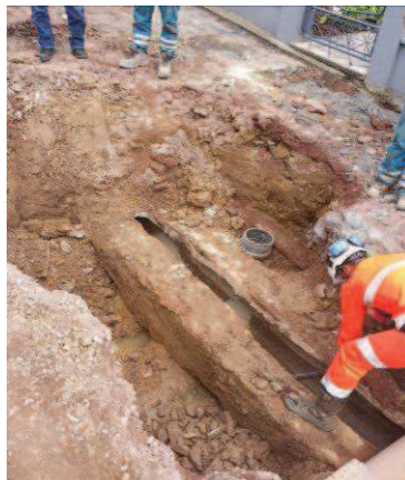
Photos des travaux sur la rue Ferrand-Eleu dit Leauwette
