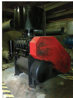
Surpresseur C (secours des deux files de traitement)
