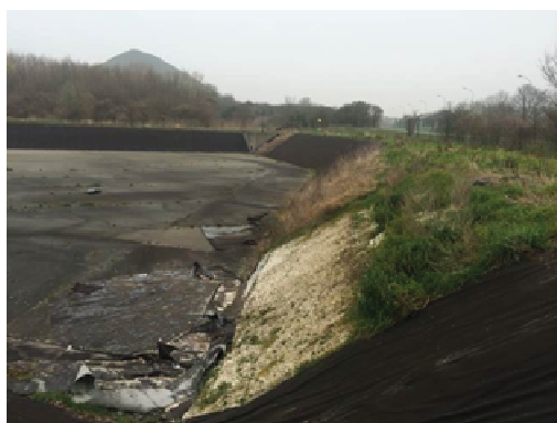
Bassin Mazingarbe - ch des soldats (avant travaux)
