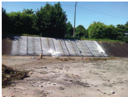
Bassin Mazingarbe - ch des soldats (après travaux)
