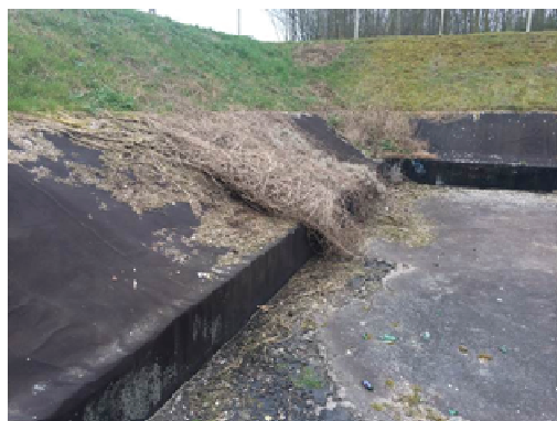
Bassin Bully les Mines - rue Emile Zola (avant travaux)
