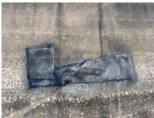
Bassin Mazingarbe - RN45 (après travaux)
