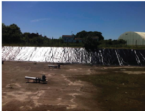
Bassin Avion Cosmonaute (après travaux)
