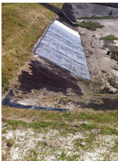
Bassin Bully les Mines - rue Emile Zola (après travaux)
