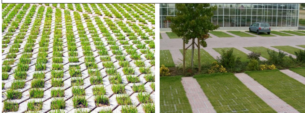
Exemples de stationnement perméable :
