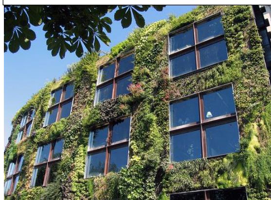
Exemple de mur végétal :
