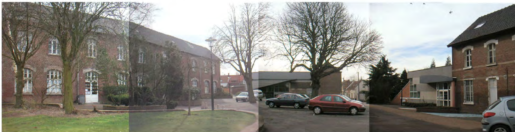
espace public derrière la mairie
